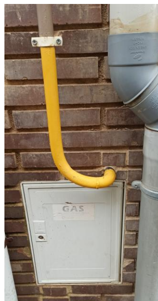
Imagen 1 Instalaciones eléctrica y de gas respectivamente
