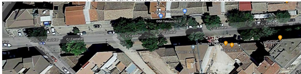
Figura 1.- calle Castelar (Zona afectada) vista aérea
